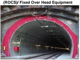
**Rigid Overhed Conductor Rail System**
