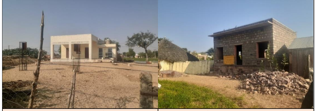
प्रकरण 14: खानोड़ी सड़क पर सार्वजनिक पुस्तकालय का निर्माण भीलों की ढाणी के पास ग्राम पंचायत, बापू नगर, पंचायत समिति शेरगढ़
