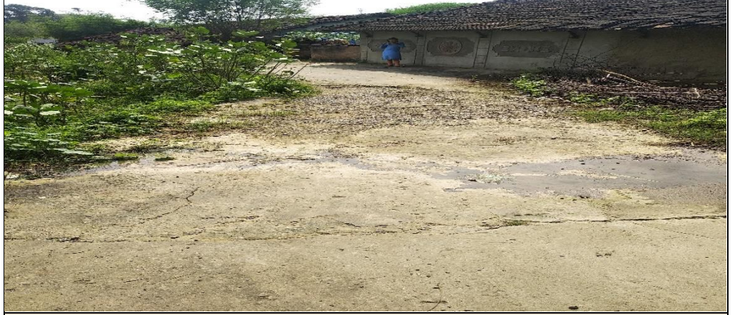
प्रकरण 3: मुख्य सड़क से कुरे सिंह/सरदार सिंह के घर की ओर सीसी सड़क का निर्माण, ग्राम पंचायत कानपुर (पंचायत समिति खैरवाड़ा)
