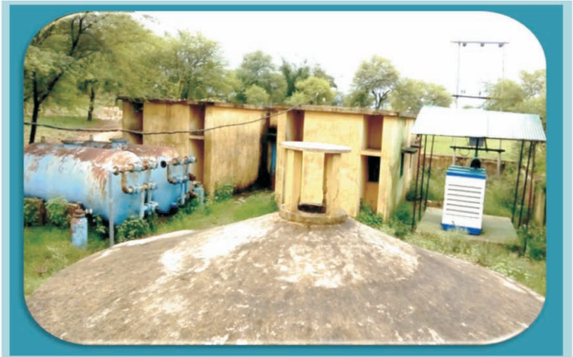
झारखण्ड के फ्लोराईड प्रभावित जीपी में गैर-क्रियात्मक एमपीडब्ल्यूएस योजना में व्यर्थ जनरेटर तथा जंग खा रहे प्रेशर फिल्टरों को दर्शाने वाली फोटोग्राफ
