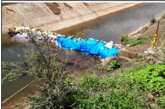
डायरेक्ट माइनर-13 को भरने के लिए एल.बी.सी. में कृत्रिम अवरोध (जुलाई 2017 की स्थिति में)
