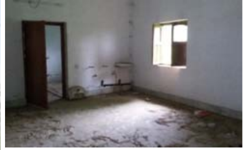
ए.एन.एम. भवन, पाकुड़ का आंतरिक भाग
