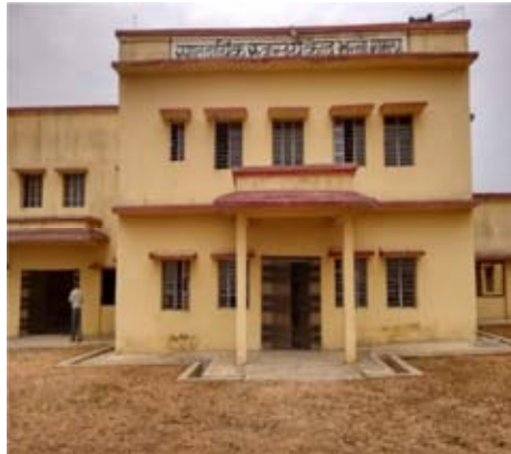
सा.स्वा.के. भरनो, गुमला के लिए निर्मित भवन अप्रयुक्त
