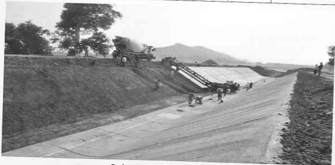
बानसुजारा परियोजना, जिला टीकमगढ़ की निर्माणाधीन नहर
