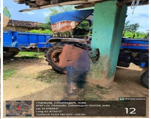
चित्र 4.4: वितरण लाइन नहीं पहुंची एवं कार्यशील घरेलू नल कनेक्शन का निर्माण नहीं किया गया (ग्राम भिथीडिह बस्ती विद्यानगर)
