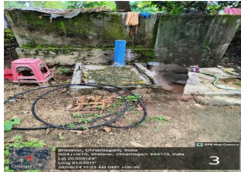
चित्र 4.5: ग्राम भिड़ावर में कार्यशील घरेलू नल कनेक्शन को कम्पोजिट पाइप के साथ वितरण लाइन से जुड़े नहीं होने को, प्रदर्शित करता चित्र
