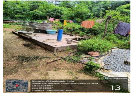
चित्र 4.5: ग्राम भिड़ावर में कार्यशील घरेलू नल कनेक्शन को कम्पोजिट पाइप के साथ वितरण लाइन से जुड़े नहीं होने को, प्रदर्शित करता चित्र
