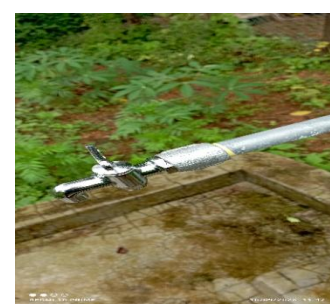
चित्र 3.2: कार्यशील घरेलू नल कनेक्शन में उपयोग हो रहे 15 मिमी नल को दर्शाती तस्वीर
