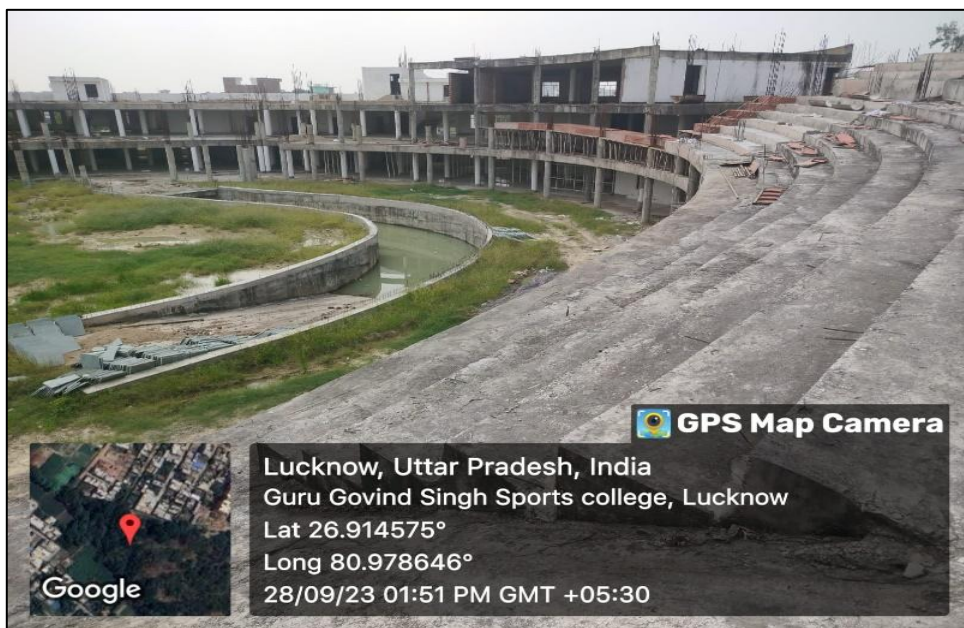
फोटो 3: वेलोड्रोम के निर्माण कार्य की स्थिति
