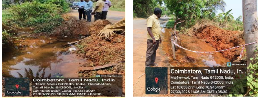
விளக்கப்படம் 2.3: குழாய்களில் ஏற்பட்ட கசிவுகளால் உண்டான நீர் தேக்கம்
