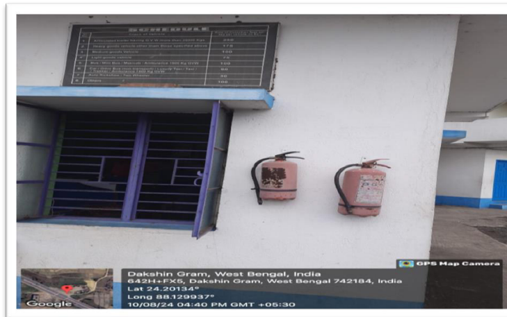
চিত্র 2.10: মরিচা পড়া ও মেয়াদ উত্তীর্ণ অগ্নিনির্বাপক যন্ত্রের ছবি
