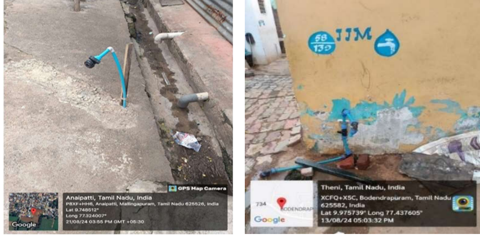
விளக்கப்படம் 7.2: கான்கிரீட் ஸ்டாண்ட் கம்பம் இல்லாமல் திறந்தவெளியில் வழங்கப்பட்ட FHTC
