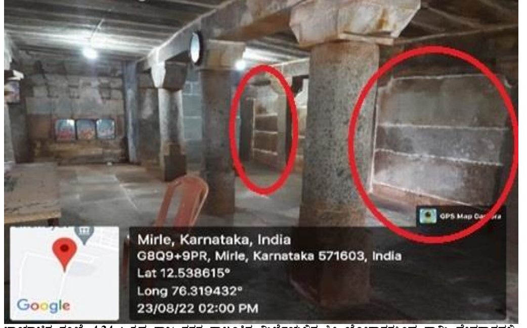
ಭಾಯಾಚಿತ್ರ ಸಂಖ್ಯೆ 4.24 : ಕೃಷ್ಣ ರಾಜ ನಗರ ತಾಲ್ಲೂಕಿನ ಮಿರ್ಲೆಯಲ್ಲಿನ ಶ್ರೀ ಯೋಗಾನರಸಿಂಹ ಸ್ವಾಮಿ ದೇವಸ್ಥಾನದಲ್ಲಿ ಬಿರುಕುಗಳನ್ನು ಭರ್ತಿ ಮಾಡುವ ಸಲುವಾಗಿ ಸಿಮೆಂಟಿನ ಬಳಕೆ ಮಾಡಿರುವುದು.
