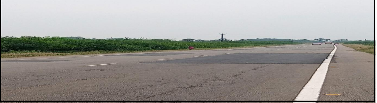
चित्र 9: संयुक्त निरीक्षण के दौरान त्रिची-कराईकुडी खंड (एनएच 36) पर असमान पैच दिखाने वाला चित्र
