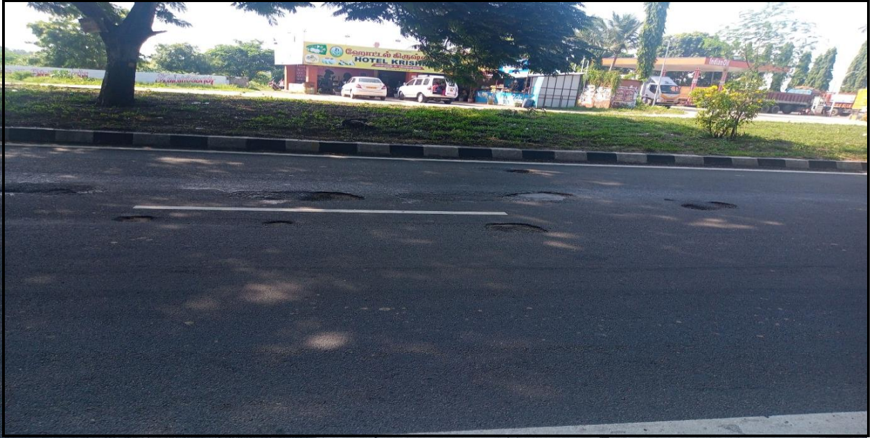
चित्र 8: संयुक्त निरीक्षण के दौरान तांबरम-तिंडीवनम खंड (एनएच 32) पर पाए गए गड्ढों का चित्र
