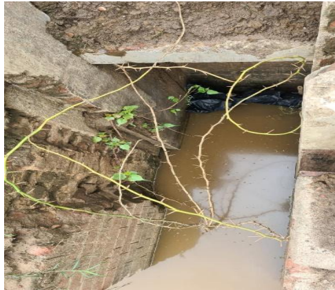
धसान नहर प्रणाली के मसूदपुरा अल्पिका के शीर्ष पर रेगुलेटर गेट स्थापित नहीं था।
