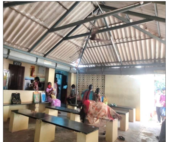
விளக்கப்படம் 3.8: மொடக்குறிச்சி நகர்ப்புற PHCல் கல்நாற் தாளின் (asbestos sheet) கீழ் இயங்கும் OP செயலறைகள்
