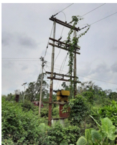
DTR (16 KVA) at Tipo kept idle/not charged
