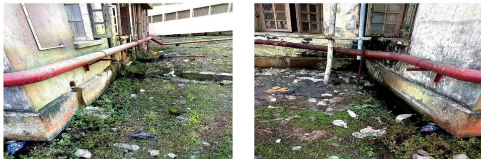
Pic 2.1.9 & 2.1.10: Plight of drainage in Balurghat DH
