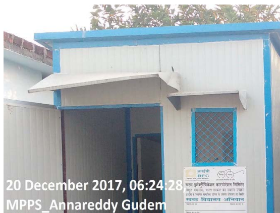
इस प्रकार की छत का निर्माण आवश्यक था
