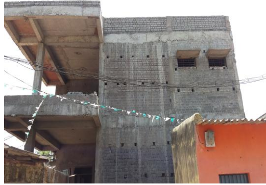
(रायगढ़ शहर का अपूर्ण जोन कार्यालय भवन)
