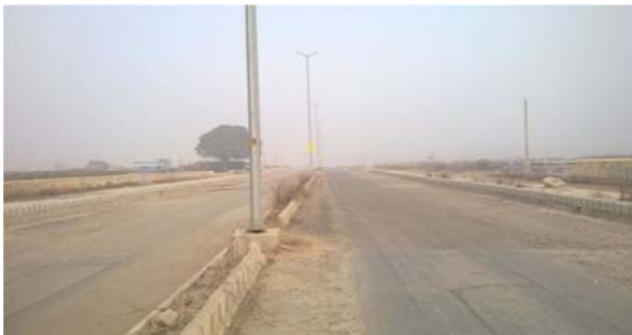
मुख्य कैरिजवे का निर्माण
