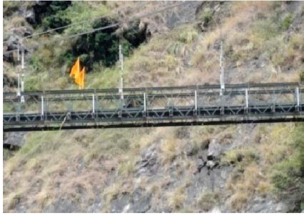
गोविन्दघाट (चमोली) में नया बैली पुल 16.10.2014
