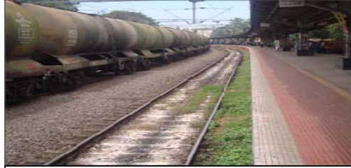
एर्नाकुलम शहर, एसआर, में लाईन/व्हीचिंग पाउडर से ढके हुए रेलपथ में मानव अपशिष्ट
