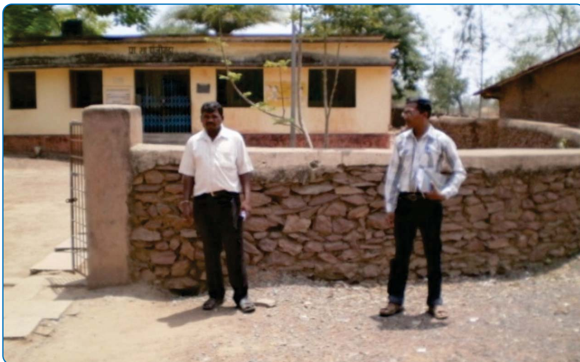
ग्राम भोंड, ब्लॉक बस्तर, जिला बस्तर, छत्तीसगढ़ में चारदीवारी का निर्माण
