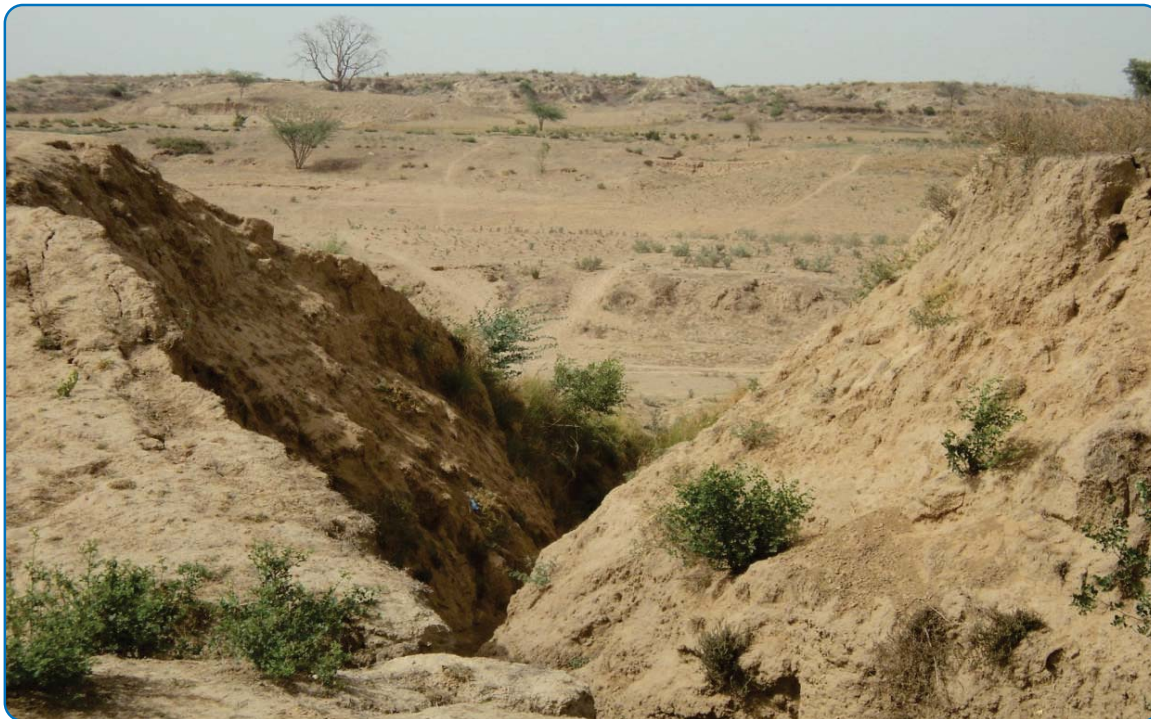
अतर सिंह की धानी, ग्रा.पं. बजना, ब्लॉक राजाखेड़ा, जिला धोलपुर, राजस्थान में टूटा हुआ बाँध
