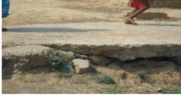
पाकुड़ जिला के सीता पहाड़ी ग्राम पंचायत में अवमानक पी.सी.सी. सड़क का फोटो।
