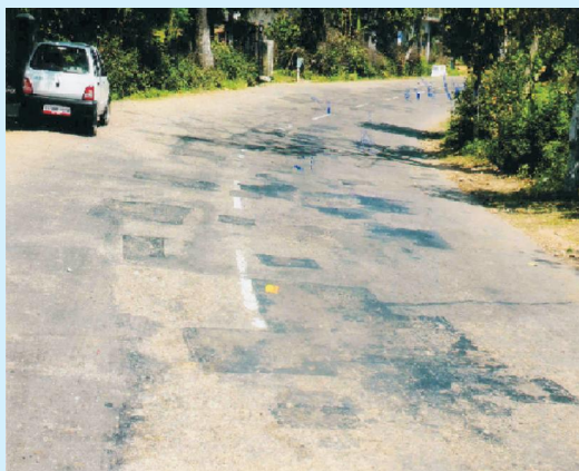
Mubarikpur-Ranital-Kangra road (km 115/200)
