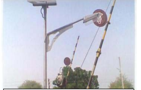
दराजपुर-मुस्तफाबाद सैक्शन, एनआर के बीच मानव संचालित समपार पर सौर पैनल
