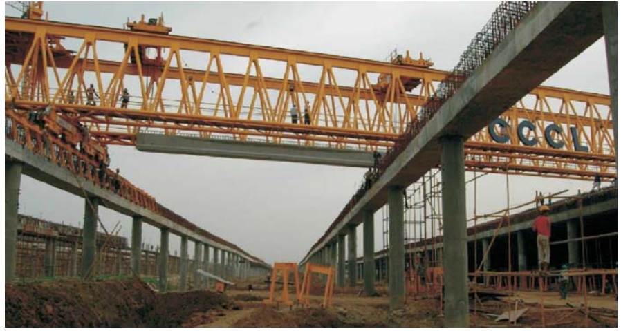
अडयार नदी पर निर्माणाधीन पुल
