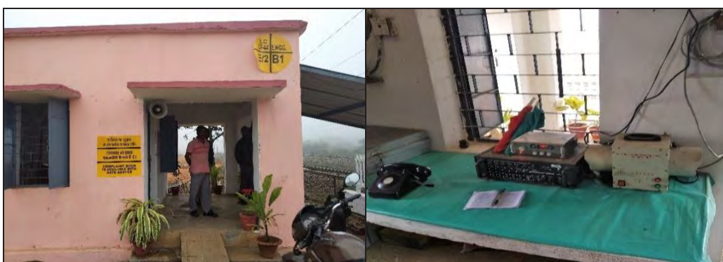
चित्र 2.21: पूरु मधुमक्खी की आवाज वाले उपकरण धनकानाल-सदाशीबपुर खंड में एलसी संख्या सीटी-44 पर संस्थापित किया।
