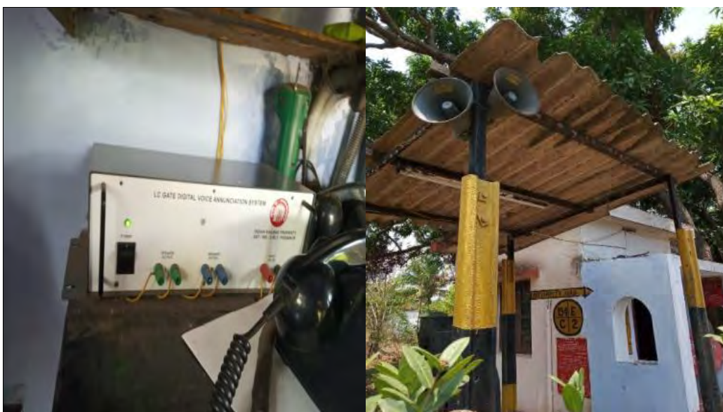
चित्र 2.23: दरे: वालायार और कांजीकोड़ के बीच एलसी सं. 154 (ए लाईन) पर मधुमक्खी की आवाज वाले उपकरण का संस्थापन
