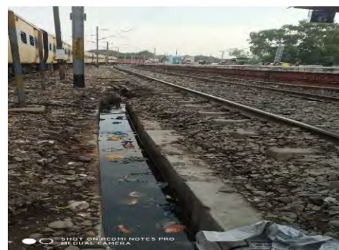
चित्र 4.1: गया (पूमरे) पर गिट्टी से रूकावट वाले प्लेटफार्म सं. 03/04 के गंदे नाले
